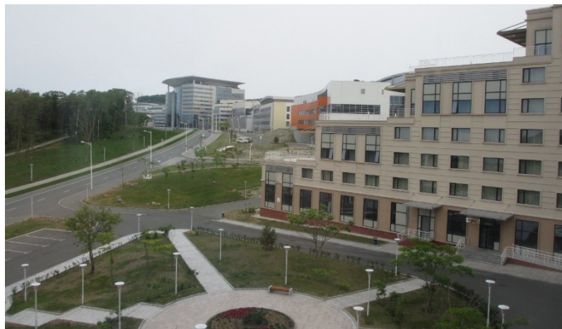
図 6 私が泊まったホテルの部屋からの風景。奥手のガラス張りの建物がキャンパス中央の APEC 本会議場。ここでは、大学入学説明会を開催していた。
